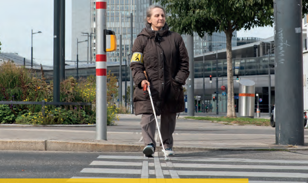
Taktile Leitlinien führen über einen Schutzweg auf die andere Straßenseite (Foto: BSVÖ Göttinger)
